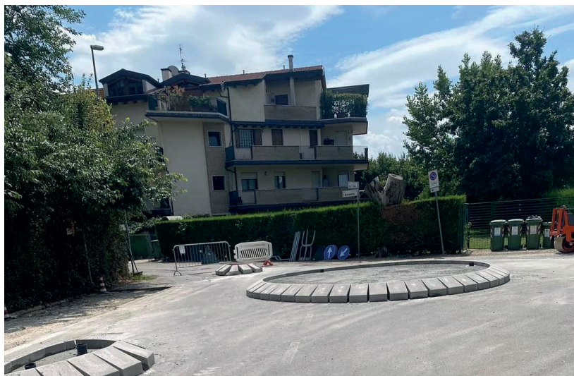
Realizzate le nuove rotatorie a Terraglione e Saletto.
