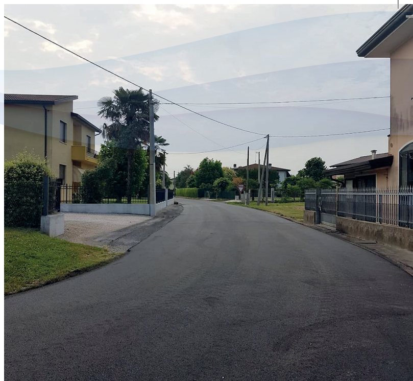
Conclusi i lavori in via Don Sturzo.
