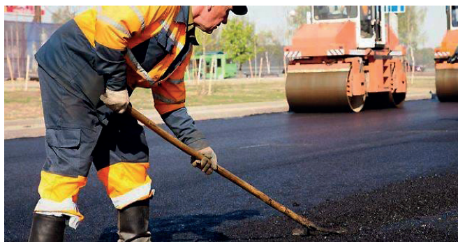
Numerosi i lavori di asfaltature delle strade in ogni frazione.
