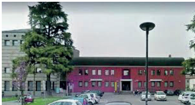
Realizzati i trasferimenti degli uffici nella nuova sede di piazza Bachelet.
